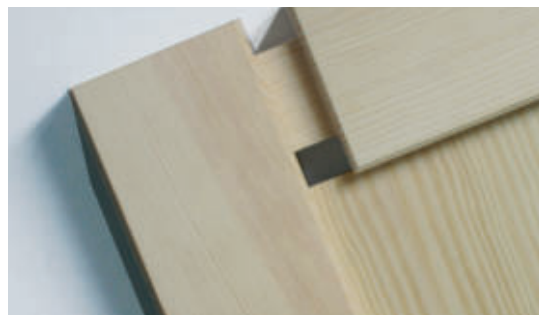
Assemblage par tenon et mortaise
